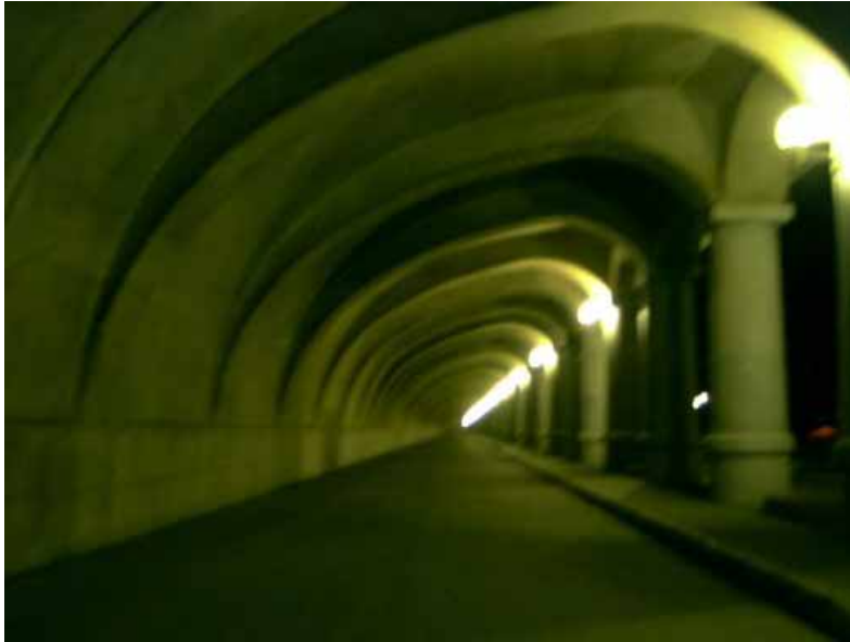
防波堤ドーム
